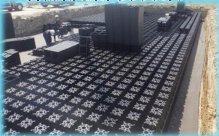
貯留槽組立の様子
